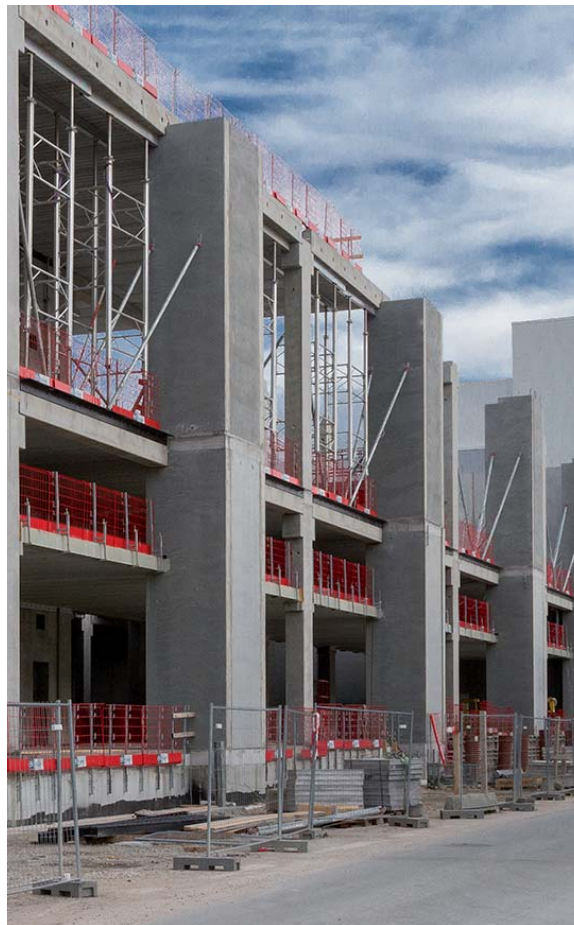
Herlev Ringvej 75, Herlev Opførelse af nyt sterilcentral på Herlev Hospital i råhusentreprise. Arkitekt: C.F. Møller A/S Ingeniør: Alectia/Niras A/S
