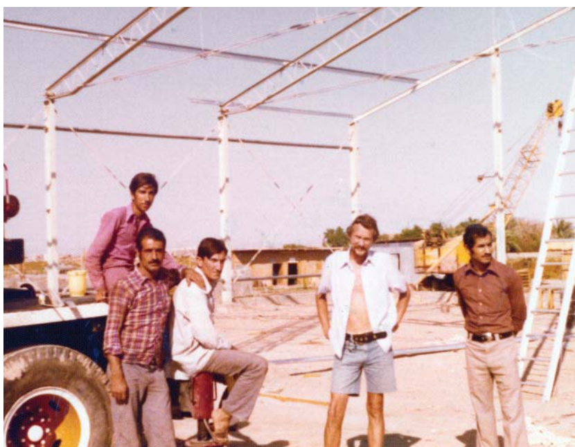
EK's byggeleder i Irak i korte bukser under skelettet til frysehuset, oktober 1976.
