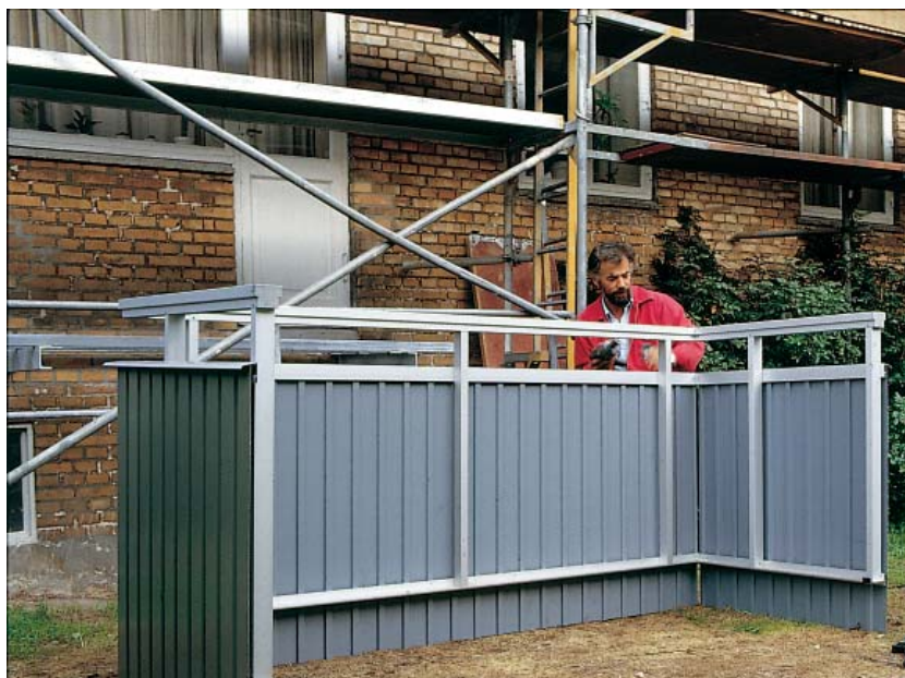
Altanrækværk klar til montering.
