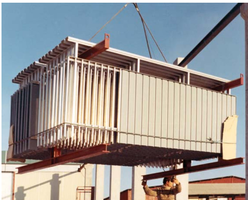
Altanelementer fra EK, klar til montering.
