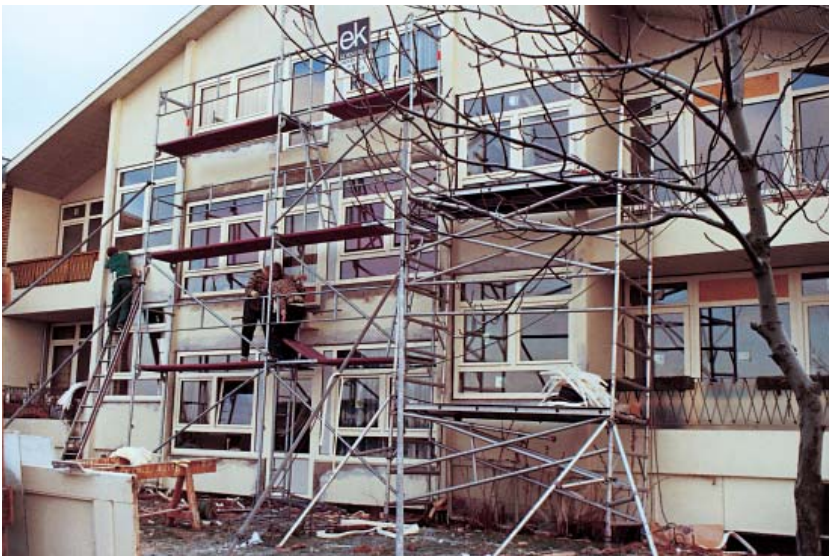
Møllevænget 5-19 i Allerød var snedkerafdelingens første større opgave med udskiftning til plastvinduer i 1975/76.
