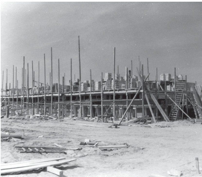
Den nye kontorbygning under opførelse på Wotanvej 1960.
