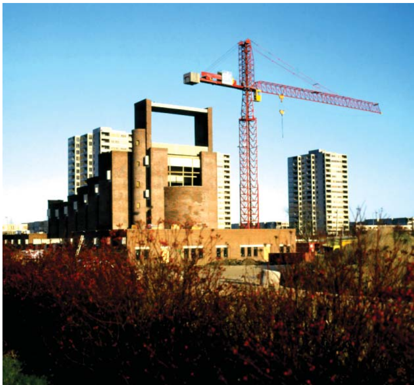
Brøndby Strand Kirke under opførelse 1982/83.
