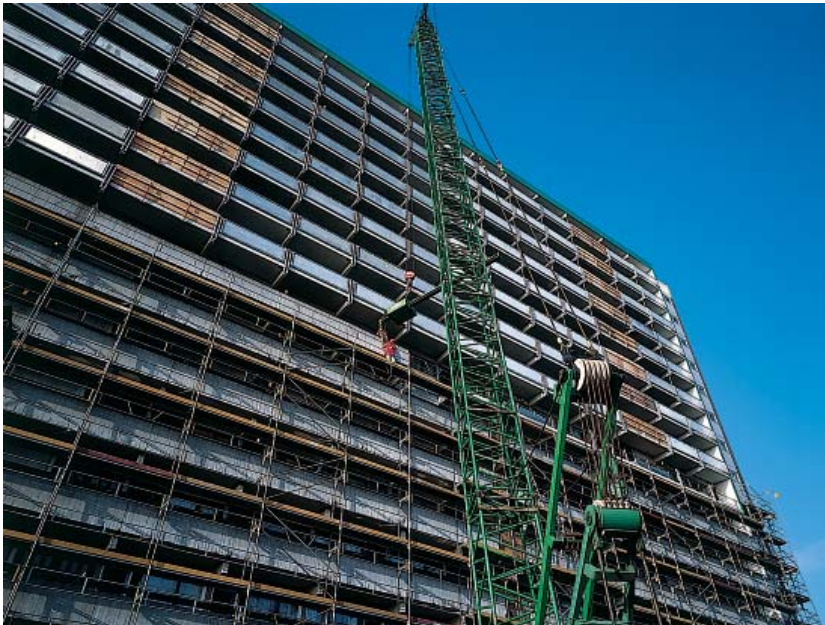
Brøndby Nord under renoveringen.
