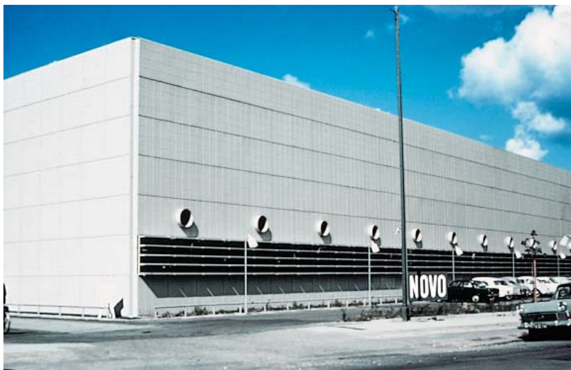
Novos 10.000 kvm. alufacade på hjørnet af Hillerødgade og Fasanvej.
