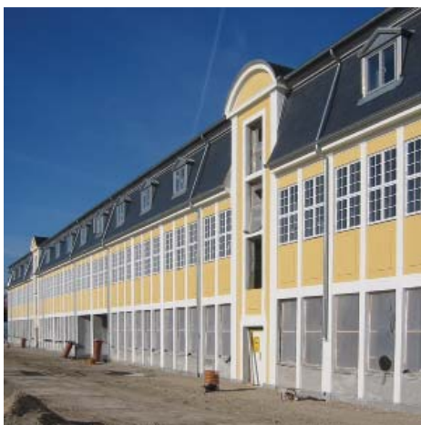
Porcelænsfabrikken Norden i slutfasen af renoveringen. På billedet til højre ses det indvendige atrium, hvor "Livets træ" efterfølgende blev plantet.
