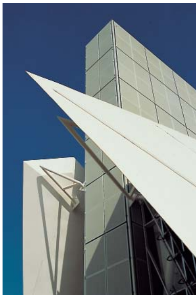
EK fik i 1991 entreprisen på fremstilling og montering af facaden på den danske pavillon på Verdensudstillingen Expo 1992 i Sevilla, Spanien. Pavillonen var på forhånd solgt til Japan (foto: KHR arkitekter AS).
