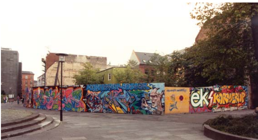
Grunden på Pilestræde 53-63, da byggeriet af Pilehuset blev indledt.
