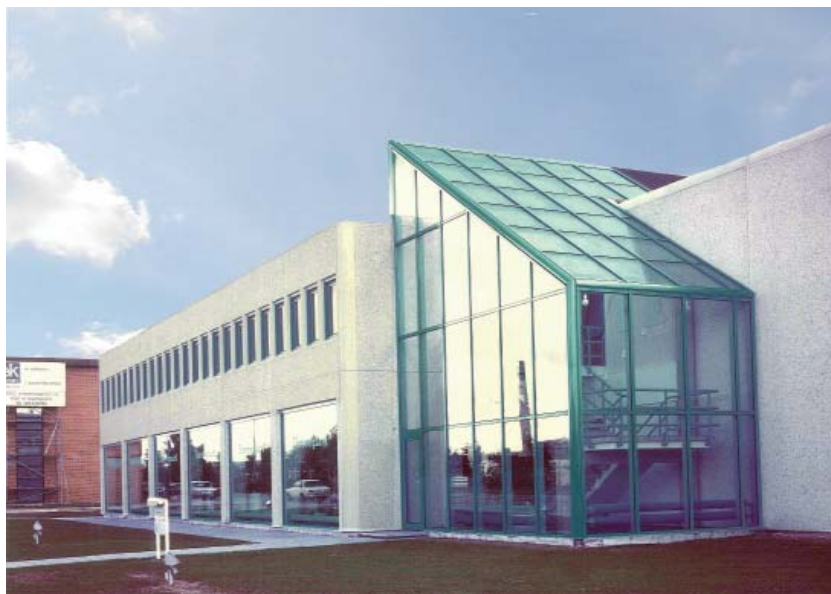
Sideløbende med udvidelsen af Korneruphus udførte EK også en totalentreprise ved opførelse af kontor-, udstillings-, og lagerbygning for Thorengaard A/S på Paul Bergsøes Vej 8.
