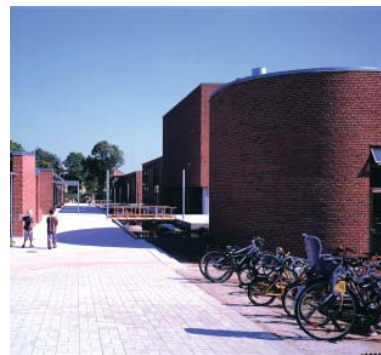
I 2002 påbegyndte EEK opførelsen af Utterslev Skole i København NV.
