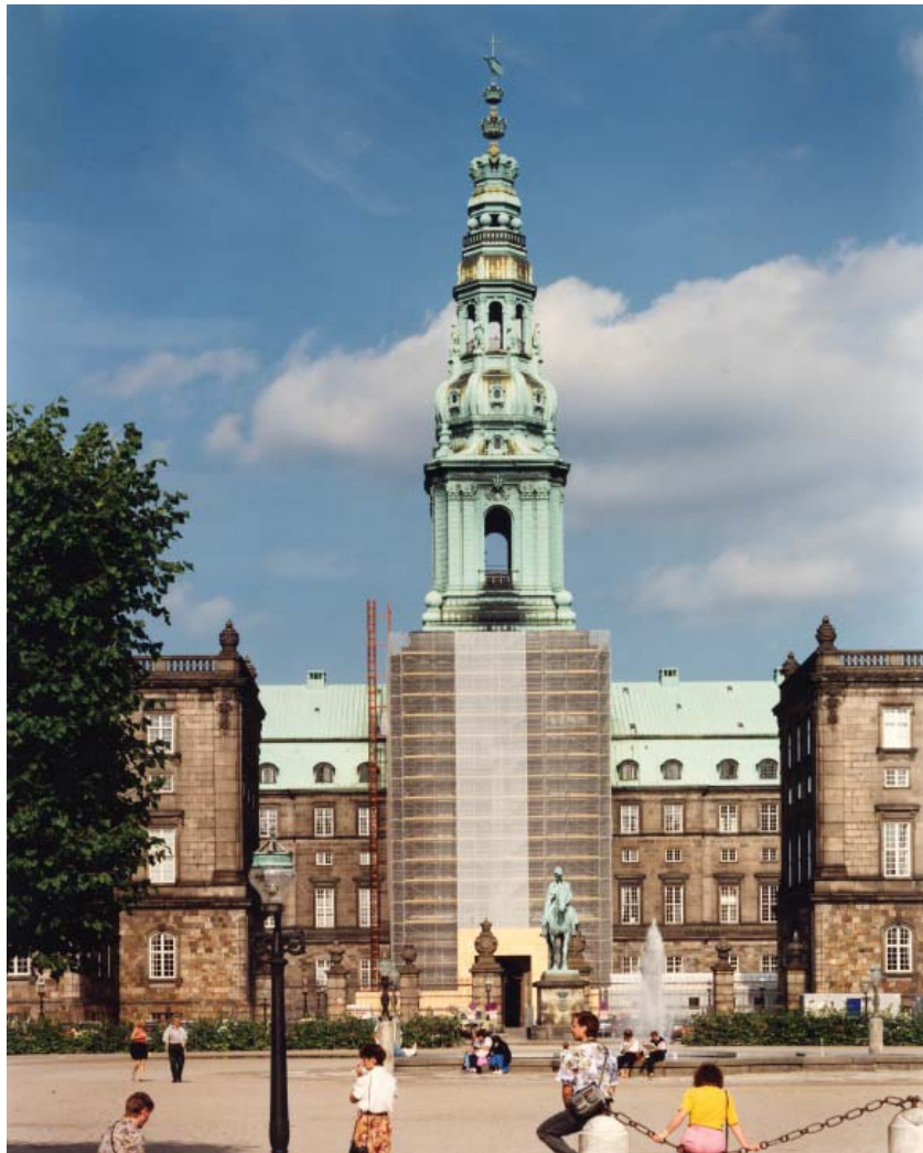
Facaderenovering på Christiansborg, 1991.
