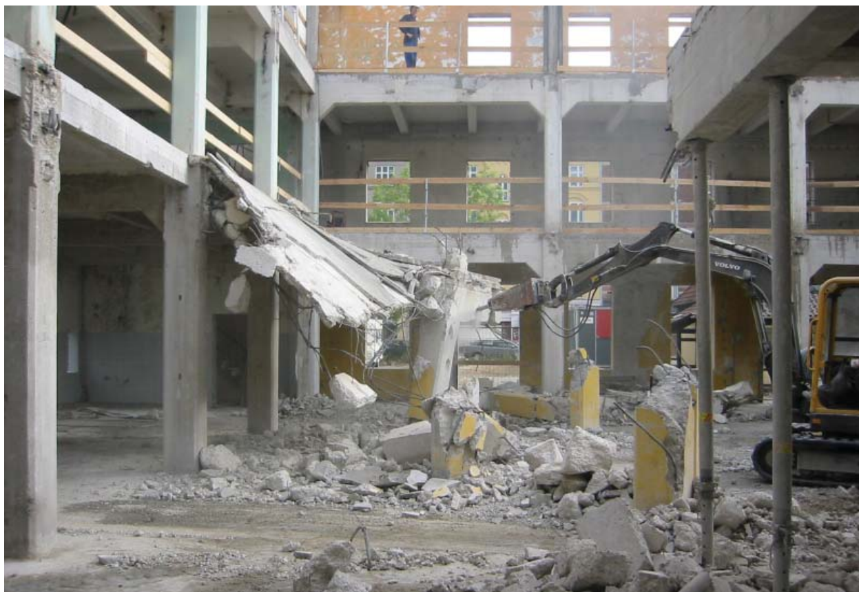
Fra nedrivningen i ovnhallen på den gamle porcelænsfabrik Norden, hvor det viste sig, at både betonsøjler og betondæk var i så dårlig forfatning, at der måtte betonrenovering til.
