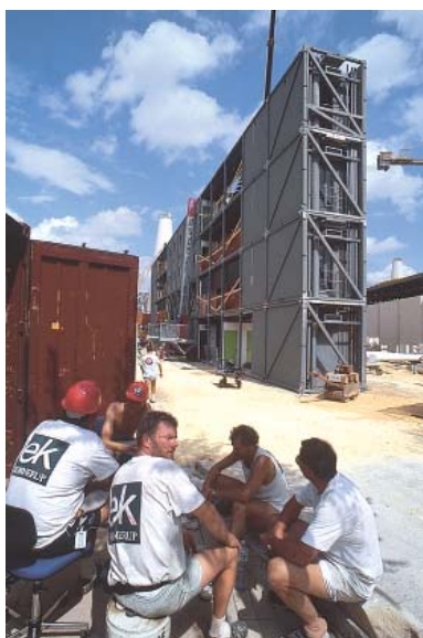
Fra opførelsen af den danske pavillon i september 1991.
