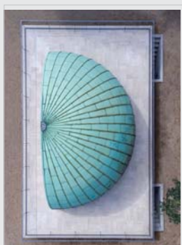
Forside: Musiktribunen i Enghaveparken set fra oven. Tribunen er ét af Arne Jacobsens første værker og er opført i 1929. Entreprenørfirmaet Einar Komerup A/S har udført betonrenovering og totalstandsættelse for Københavns Kommunes Teknik- og Miljøforvaltning.
